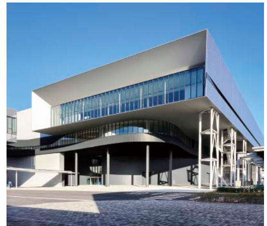
安川テクノロジーセンタ 外観
